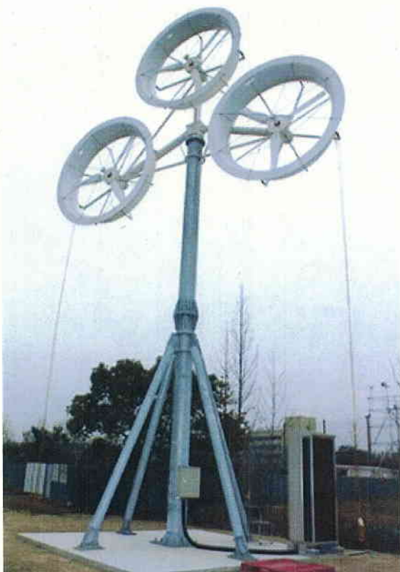
福岡県春日市にある九州大学筑紫キャンパスに設置したマルチローターシステムの風力発電装置
